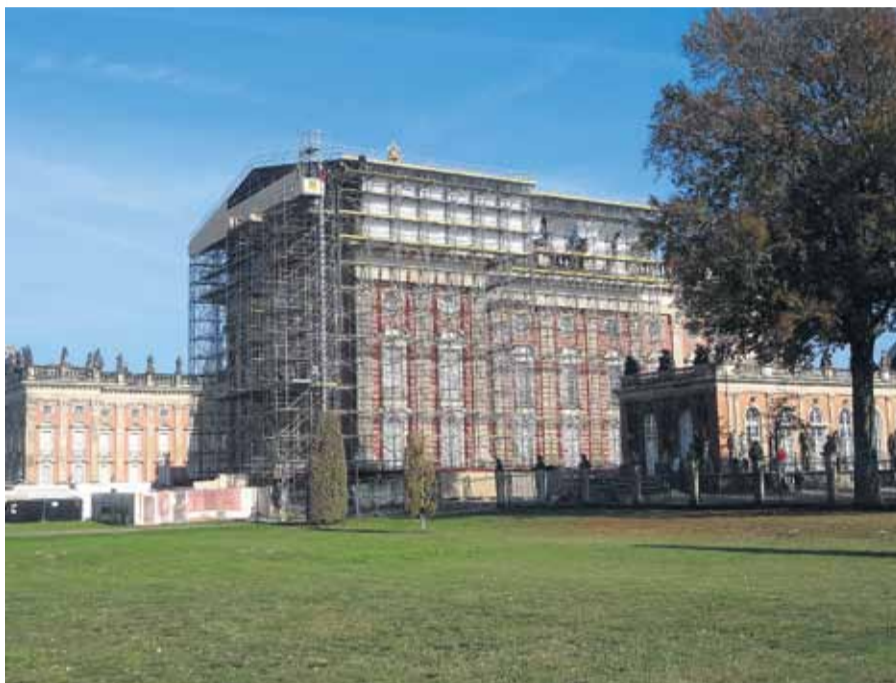
Trotz Baugerüst und Wetterschutzdach – hier am Theaterflügel – ist das Neue Palais im Park Sanssouci für Besucher geöffnet. Foto: Kerstin Laurenz
