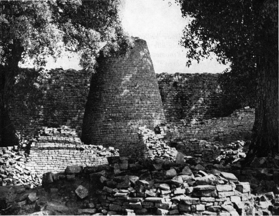
Blick in den Innenraum der unteren Ruine. Vor dem konischen Turm und der Begrenzungsmauer sind Mauerreste aus Granitziegeln und dunklen Phonolithbruchstücken erkennbar (vgl. Zeichnung von Carl Mauch Seite 61).
