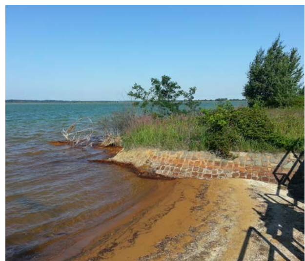
Abb. 3: „Eisenerker“-Ausfällungen im Uferbereich des Schlabendorfer Sees infolge von Kalkungsmaßnahmen zur pH-Wert-Anhebung. Die hohen Sulfatkonzentrationen werden dadurch nicht gesenkt. (2015, Foto: D. Zak)
