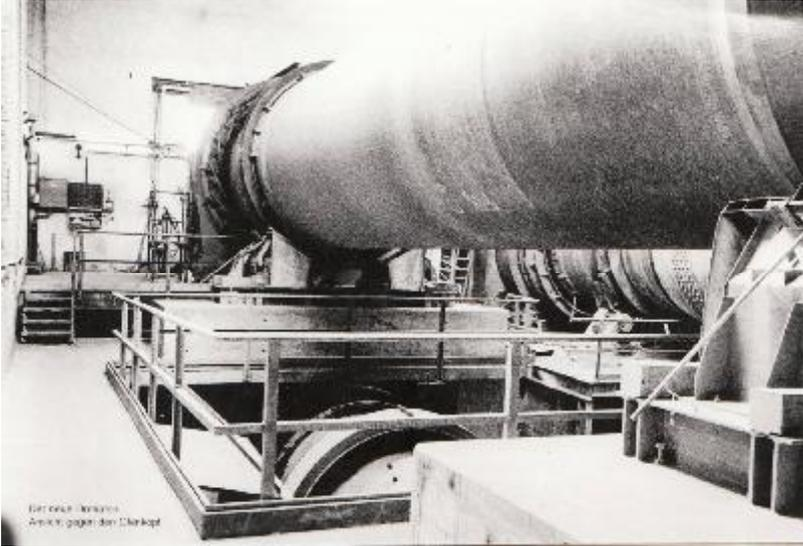
Drehrohr zur Zementerzeugung in Lorüns
