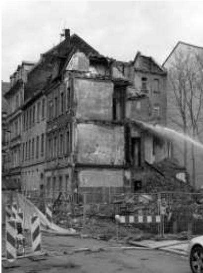
13. März 2008: Der Abriss von Rabet 58 und 60 hat begonnen.
