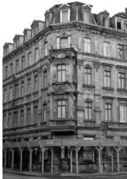
Nach Jahren drohenden Abrisses ist die Fortexistenz des schönen Eckgebäudes Hermann-Liebmann-Str. 43 nun gesichert.
