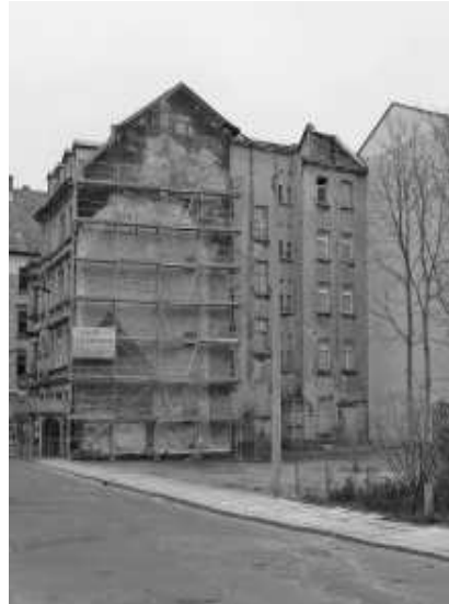
19. April 2008: Fürs erste entsteht hier ein Rasenstück.
