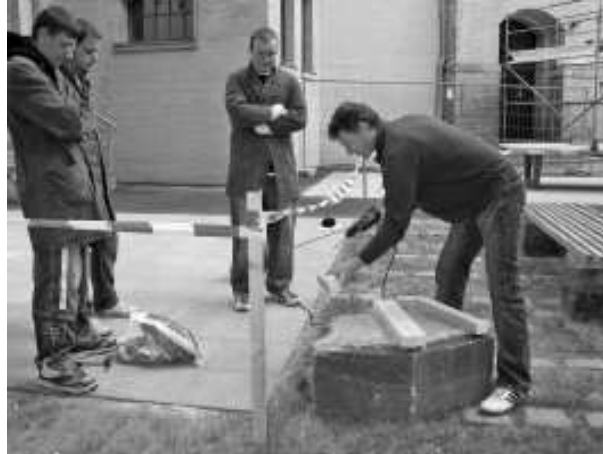
Die Montage des letzten Sitzelementes war wie alle vorhergehenden Arbeiten Bestandteil des Unterrichts.
